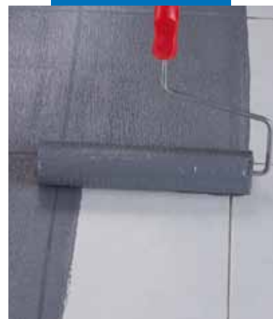
Nanášení Eco Primu Grip válečkem na stávající keramickou dlažbu z gresu
