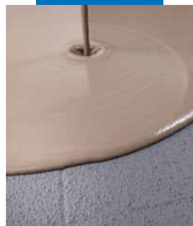
Nanášení samonivelační stěrky Ultraplán na suchý Eco Prim Grip aplikovaný na staré podlaze
