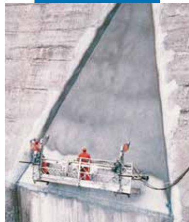
Ukázka Mapelasticu aplikovaného nástřikem na přehradní hráz
