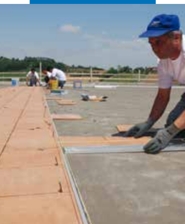
Pokládka keramiky Kerabondem + Isolasticem
