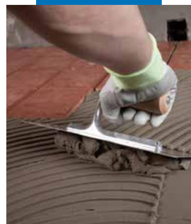
Nanášení Granirapidu na terazzo izolované Mapelasticem
