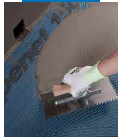
Nanášení Mapelasticu na Mapenet 150
