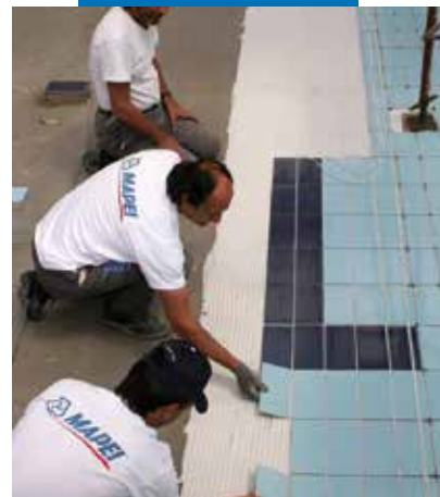
Pokládka keramické dlažby na podklad z Mapelasticu v bazénu
