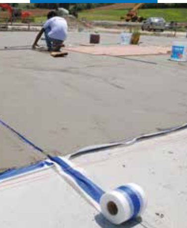
Hydroizolace potěru Mapelasticem a Mapebandem
