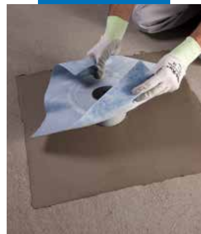
Instalace podlahové vpusti Drain Vertical na Mapelastic
