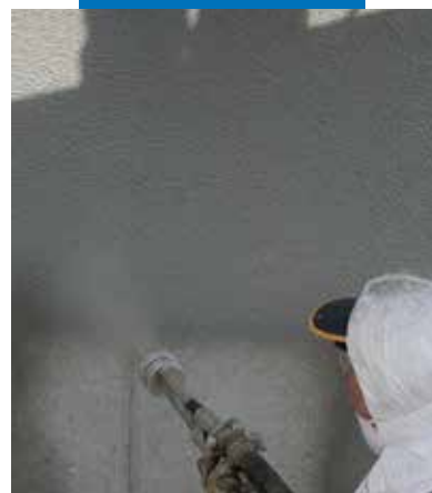
Ukázka Mapelasticu aplikovaného nástřikem na viadukt
