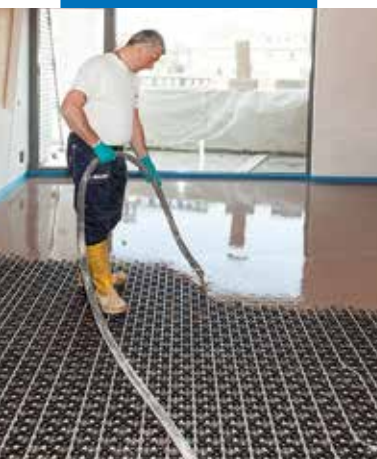
Aplikace směsi a vyplnění topných panelů tenkovrstvým systémem
