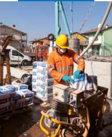
Příprava a čerpání směsi Novoplanu Maxi s použitím čerpadla s kontinuální míchačkou
