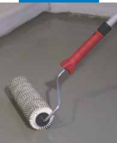
Odpowietrzanie masy Planolit 315 rulonem kolczastym
