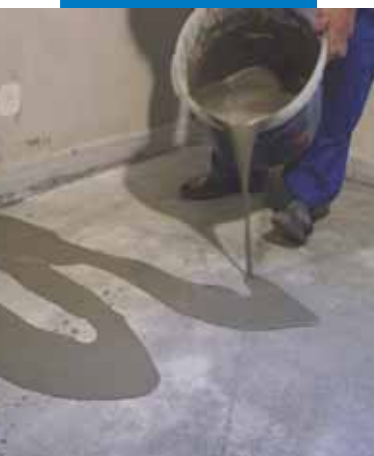
Lití směsi Planolitu 315 na podklad ošetřený Primerem G
