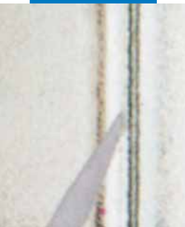
Těsnění skleněných "U" profilů
