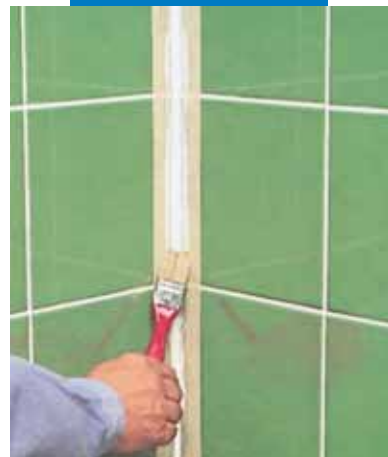
Vyhrazení povrchu spáry saponátovým roztokem a štětcem
