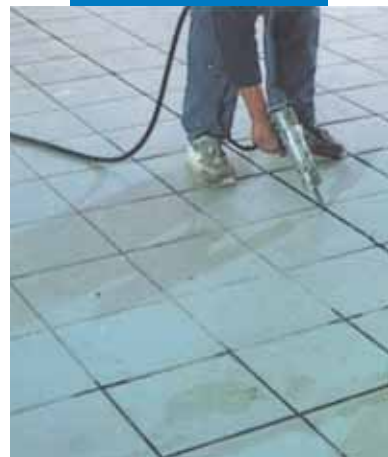
Těsnění spáry Mapesilem AC v keramické dlažbě
