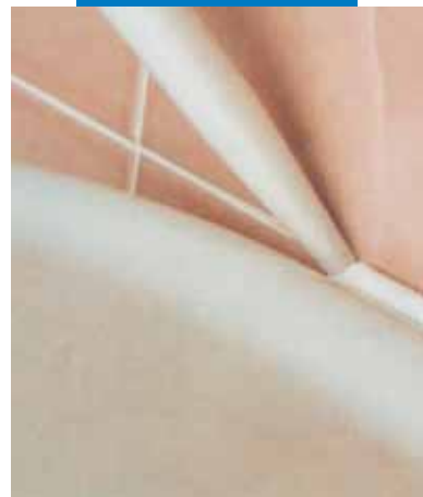
Těsnění spáry u sanitárních předmětů
